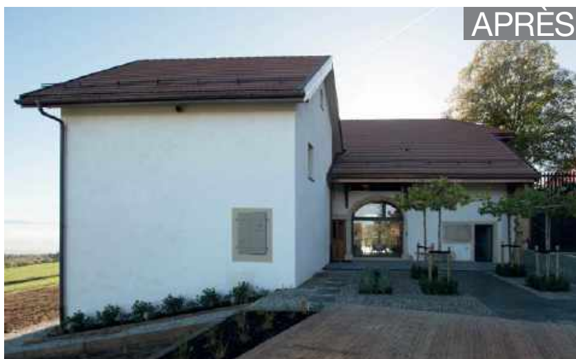
Façade est, avant/après. La baie vitrée a été placée à l'arrière de l'arche, au-dessus de laquelle une ouverture a été créée pour éclairer le loft.
