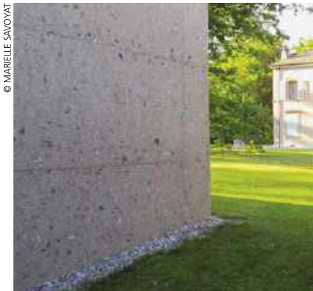
Béton désactivé sur les murs.
