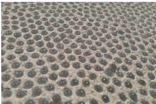
Béton réfléchissant. Des billes de verre sont enchâssés à la surface.
